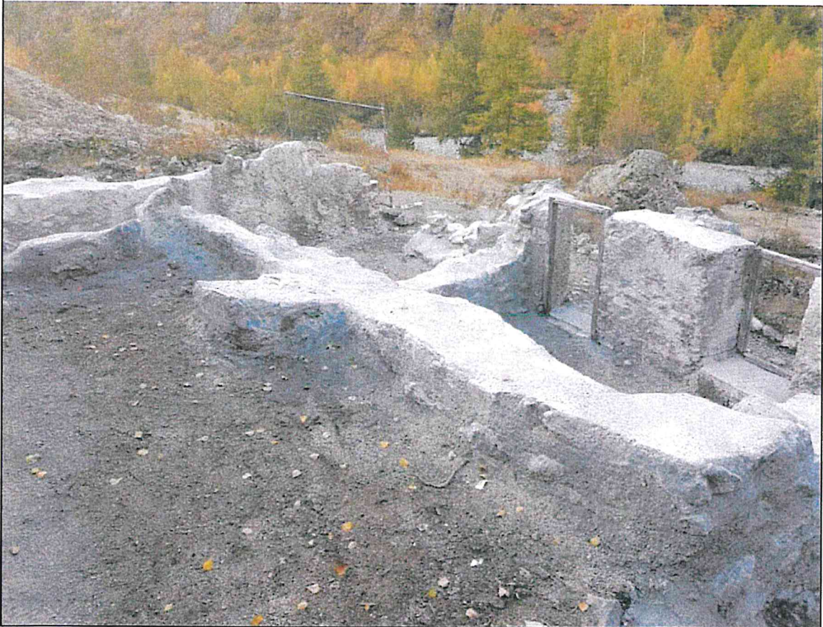
Murs et arases de la ruine aval, fraîchement achevés
