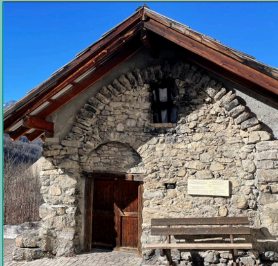
Travaux d'entretien et d'embellissement du four banal du Grand Parcher
