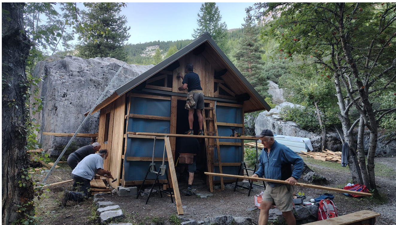
Travaux de rénovation et de confortement
